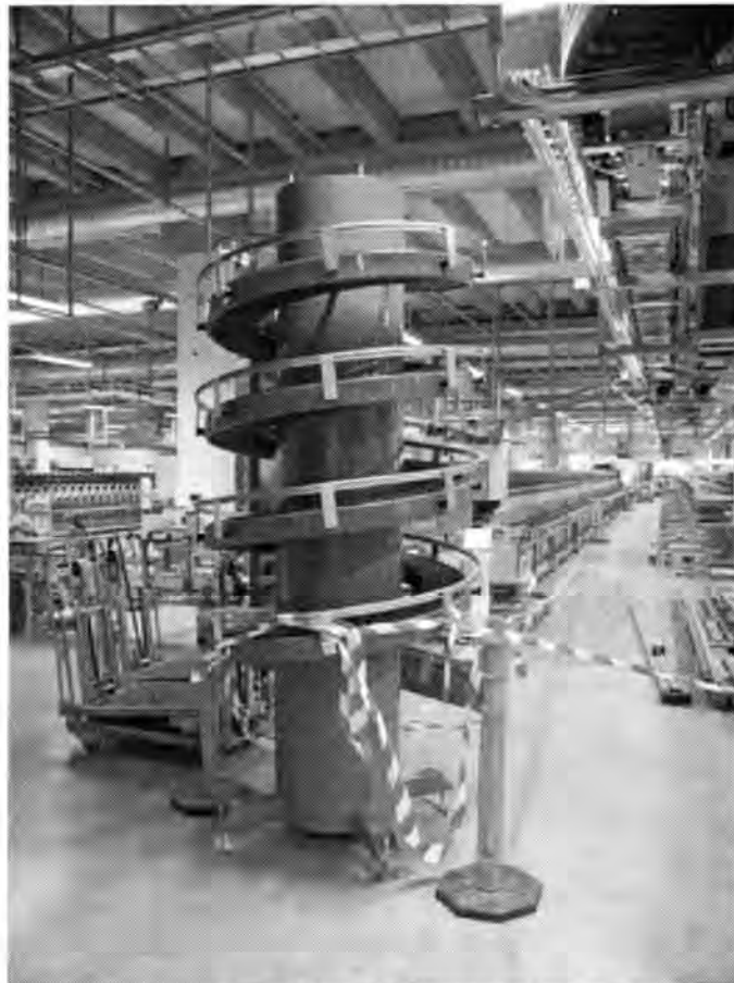
Nu har den finska skruvhissen för lådor nått Sverige. Två stycken installeras på Årsta.
