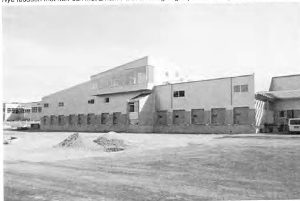
Nya fasaden mot norr och mot E4:an. På övervåningen glaspartiet i det nya lunchrummet.
