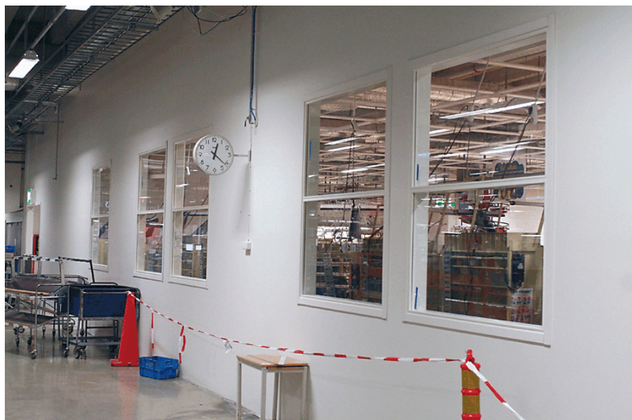
Nya väggen mot manuella sorteringen – ett resultat av arbetsmiljöarbetet på Årsta!
