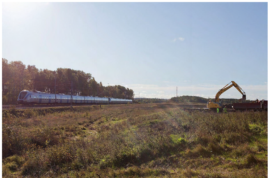
Markarbetena har inletts för Rosersbergsterminalen, 23 september 2011.
