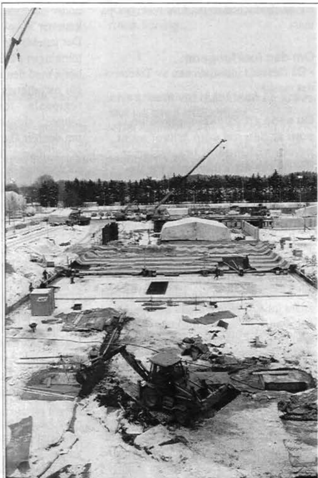
...mot Årsta. Sth Syd kl.13.30 den 10 februari. Utsikt mot öster från nuvarande byggnad. Gjutningen har börjat.
